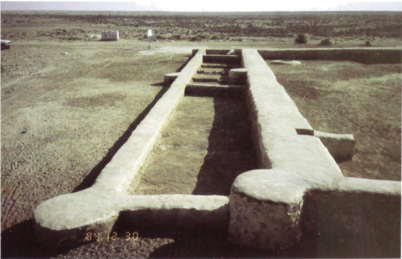
مروب - الجدار الشرقي للقلعة الثانية يتقدمه الجدار الشرقي للقلعة الأولى بعد الإنتهاء من أعمال الترميم
